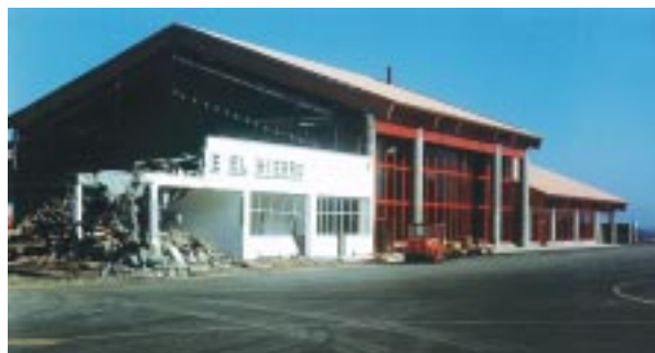
Antigua terminal junto a la actual, en construcción.
